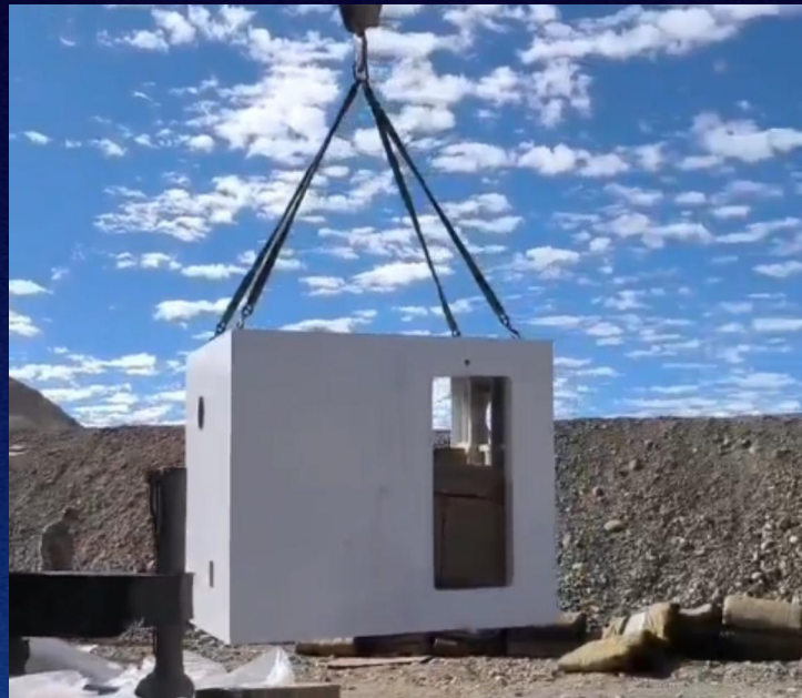
西藏阿里某工程 供氧项目 海拔4500米
